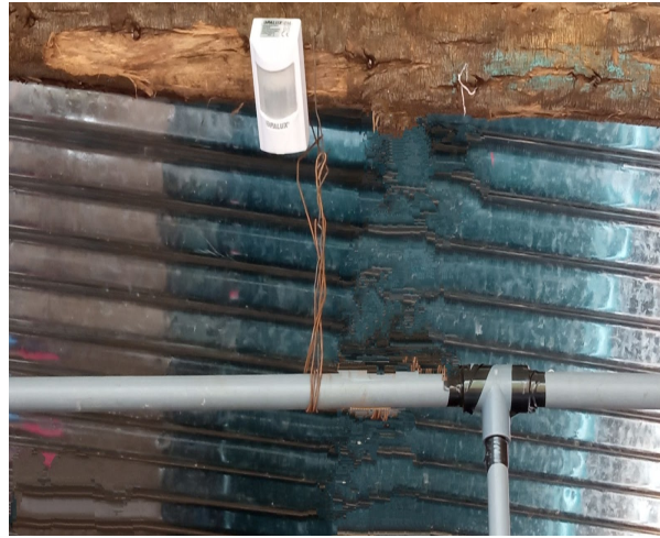
Figura 18 Ubicación de sensor de presencia en area de lavado de vehículos para activación del proceso de enjuague de vehículo
